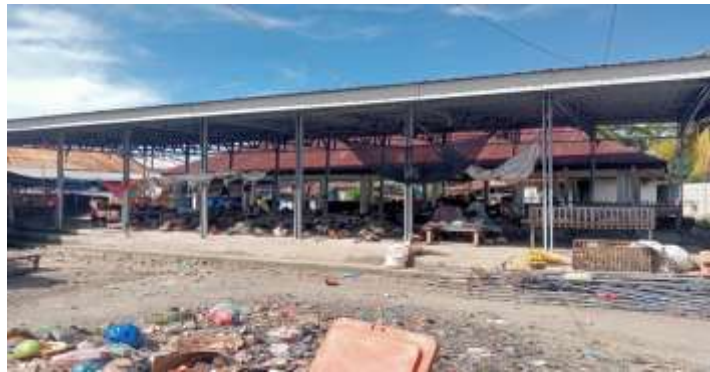
Gambar 2 Bangunan Los Petak Ayam Baru
