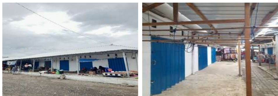
Gambar 3 Pembangunan Gedung Kios Baru
